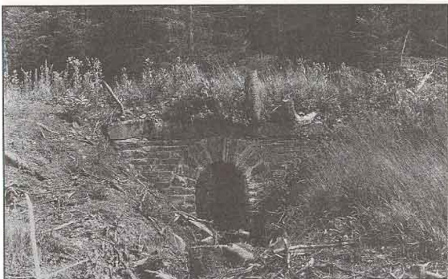
Jeden ze zachovalých propustků na bývalé trati. 27.7. 1985.
