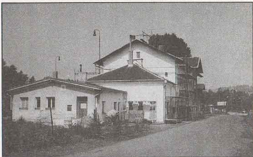
Železniční stanice Ondrášov nese název Moravský Beroun. Místo kolejíště úzkorozchodné dráhy zde najdeme asfaltovou cestu. 8.7. 1989.
